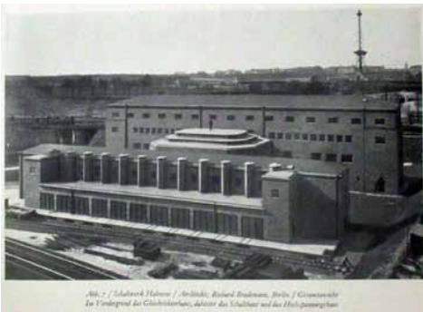
Abb. 7 | Schaltwerk Halensee / Anhalter, Richard Brademann, Berlin / Gesamtansicht Ein Vordergrund des Gleichrichterwerks, dahinter das Schaltwerk und das Hochspannungsgitter
