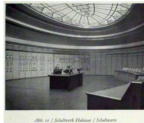
Abb. 10 | Schaltwerk Halensee / Schaltwarte
