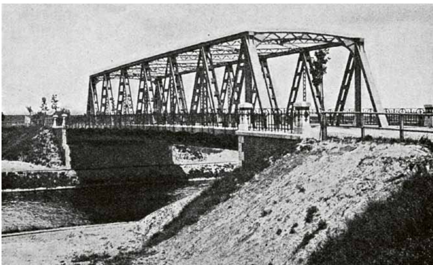
Die Massantebrücke über dem Teltowkanal in Rudow, 1906; 2003 durch einen Neubau ersetzt. Zeitschrift für Bauwesen, 56. Jg. (1906), Sp. 645
