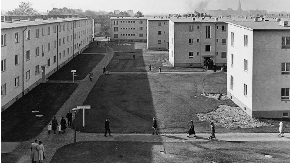
Das Aufnahmelager nach der Fertigstellung des ersten Bauabschnitts, 8. Oktober 1953. Die Anlage lässt die beabsichtigte langfristige Nutzung als Wohnsiedlung deutlich erkennen. Foto: Landesarchiv Berlin
